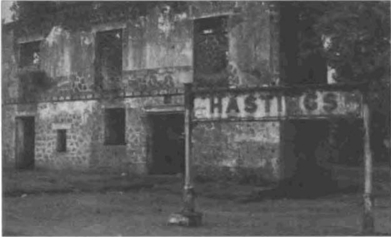
۲۱- تخریب غیرعلاق: ایستگاه راه‌آهن متروکه «هاستینگ» در مسیر «بو» در سیرالئون
